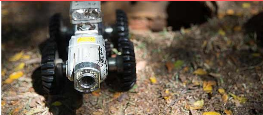
Robô da Sabesp que percorre os dutos de esgoto na Grande SP
